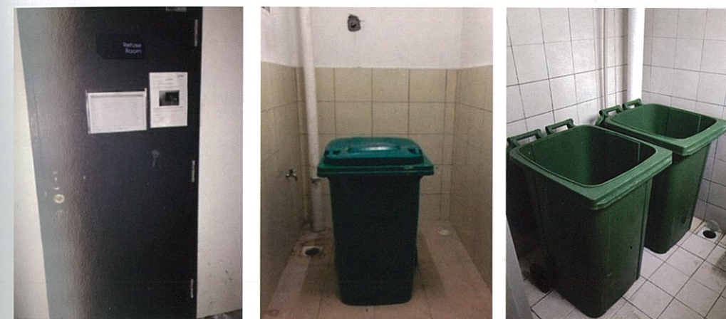
Gambar 29: Kebuk sampah bagi pembangunan berbilang tingkat
